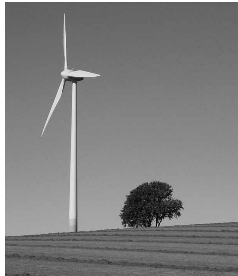
Ανεμογεννήτρια ισχύος 1,8 MW –ένα τυπικό μέγεθος μονάδας για συστοιχίες αιολικών πάρκων. Είναι χαρακτηριστικό το μέγεθός της σε σύγκριση με το δέντρο που βρίσκεται δεξιά της, ενώ πρέπει να σημειωθεί ότι δεν αποτελεί τον μεγαλύτερο διαθέσιμο τύπο Α/Γ.
