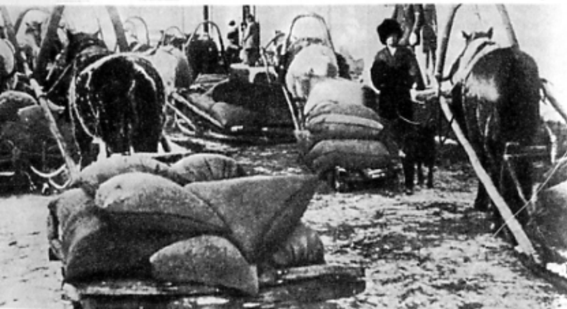
Τό σάρι τού παρακατήματος μεταφέρεται από τούς χωρικούς στα κέντρα συγκέντρωσεως.
